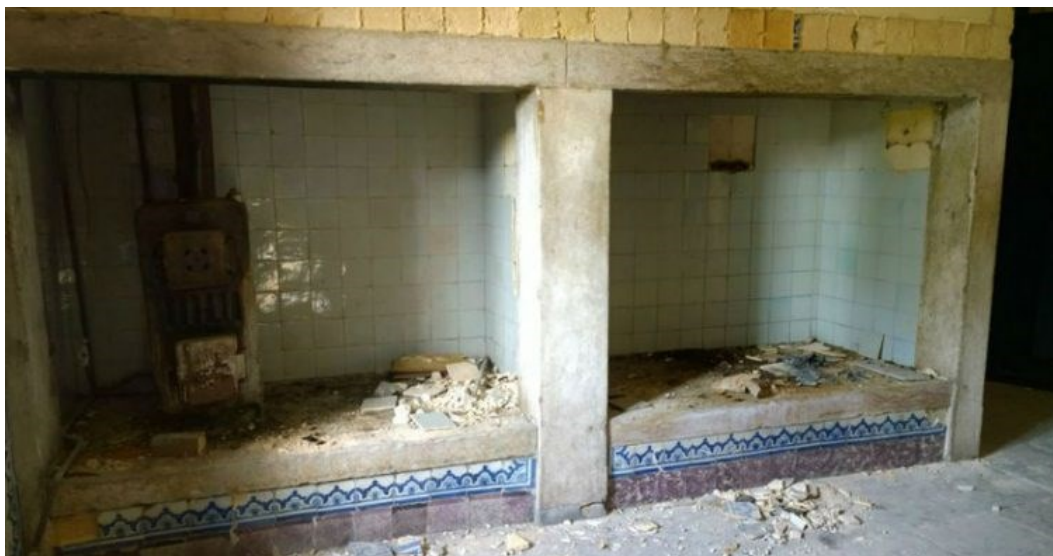
Anexo 42 – Vista da cozinha do Palácio, Alcântara, NiT - Lugares Abandonados, 2016
