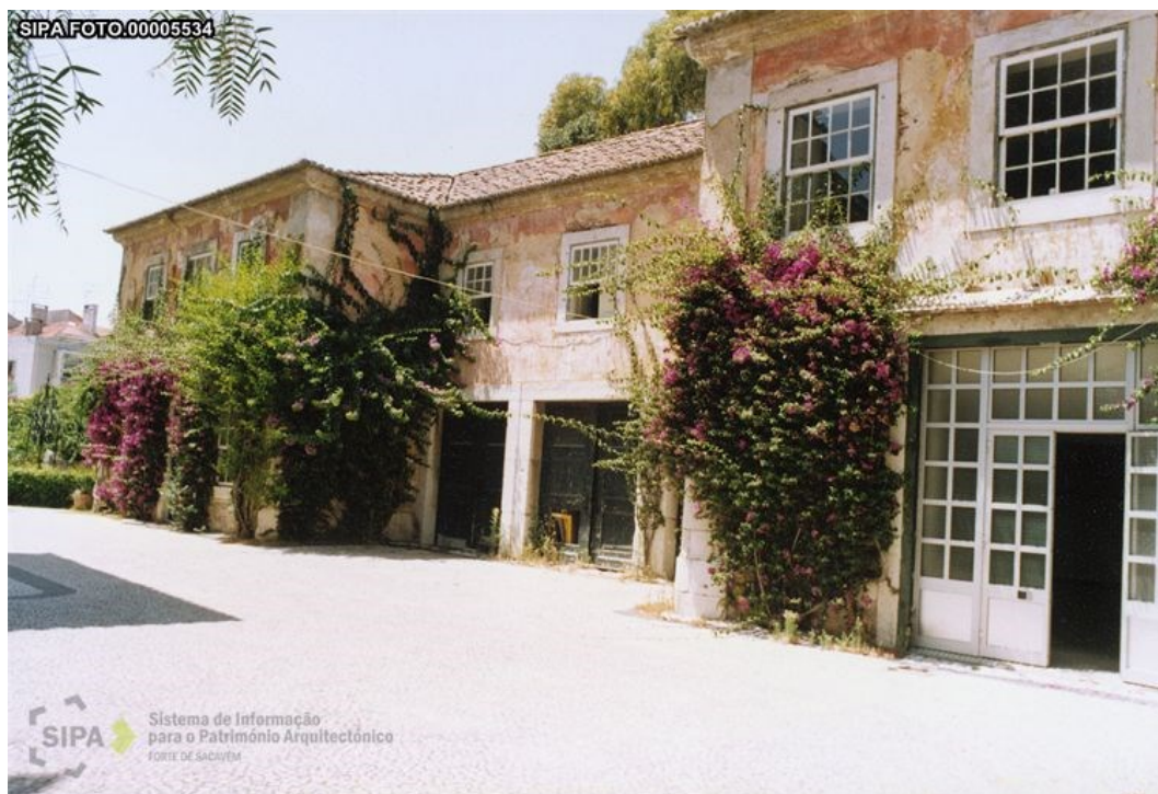
Anexo 16 – Fachada Sul do edifício anexo ao Palácio, Alcântara, Teresa Vale e Carlos Gomes, 1993, João Marques e Ricardo Porfírio, 2003
