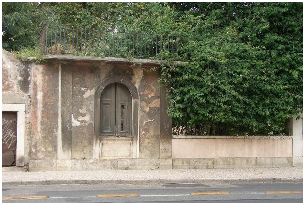
Anexo 45 – Vista do muro exterior, Rua da Junqueira, Alcântara, DGPC, 2018
