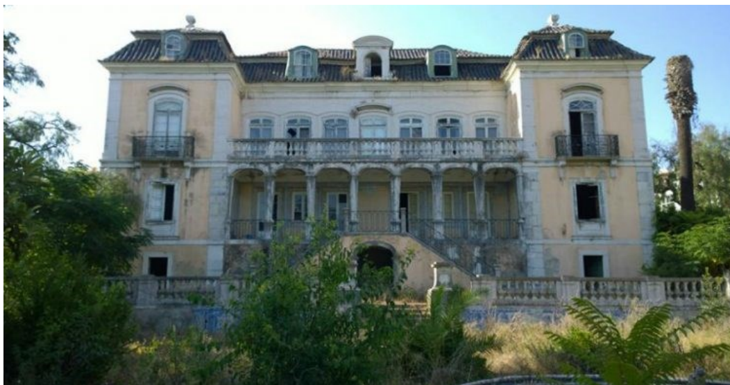
Anexo 35 - Fachada Sul do Palácio, Alcântara, NiT - Lugares Abandonados, 2016
