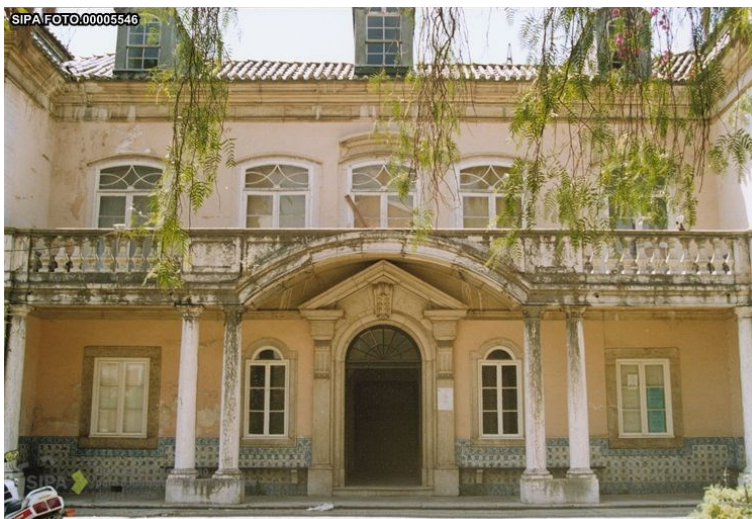
Figura 22 - Entrada principal, fachada Nascente (Vale, Gomes, Marques, & Porfírio, 1993 e 2003)
