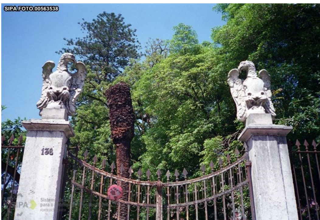
Anexo 23 – Portão de acesso á Quinta, Rua da Junqueira, Alcântara, Teresa Vale e Carlos Gomes, 1993, João Marques e Ricardo Porfírio, 2003
