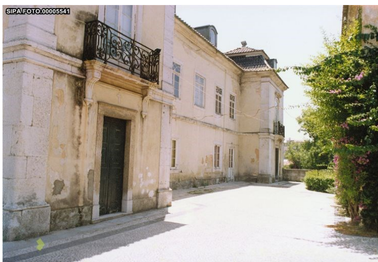
Figura 23 - Fachada Norte (Vale, Gomes, Marques, & Porfírio, 1993 e 2003)
