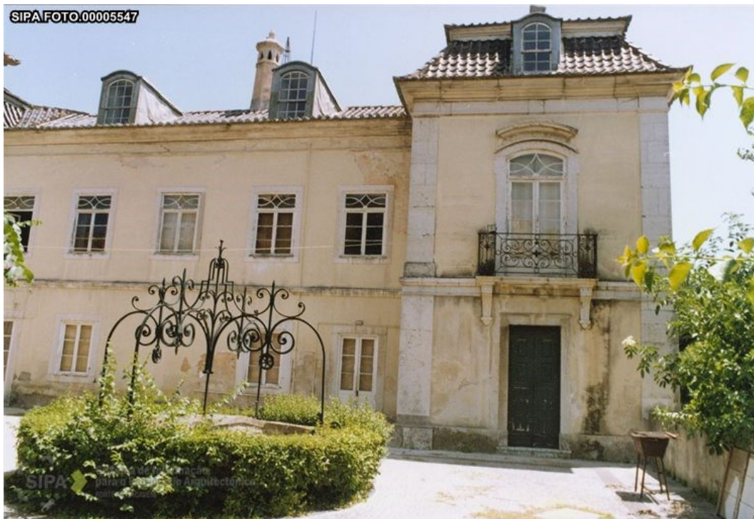
Anexo 15 – Fachada Norte do Palácio das Águias, Alcântara, Teresa Vale e Carlos Gomes, 1993, João Marques e Ricardo Porfírio, 2003
