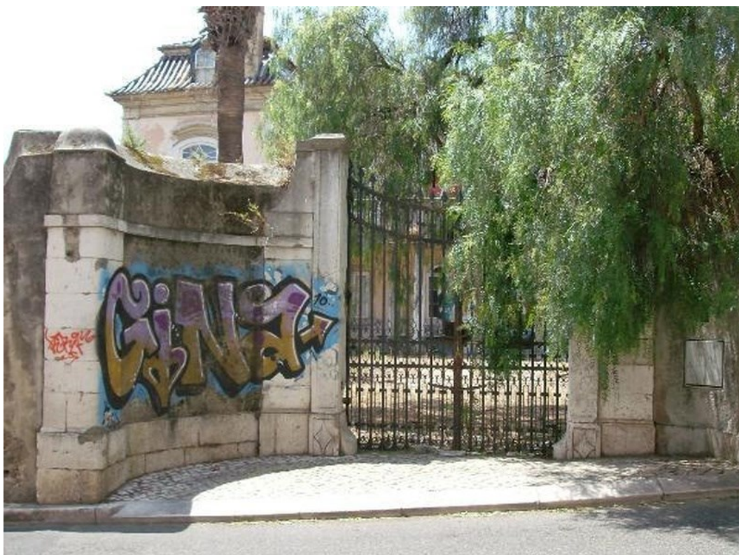
Anexo 47 – Vista do portão principal, Rua da Boa Hora, Alcântara, DGPC, 2018
